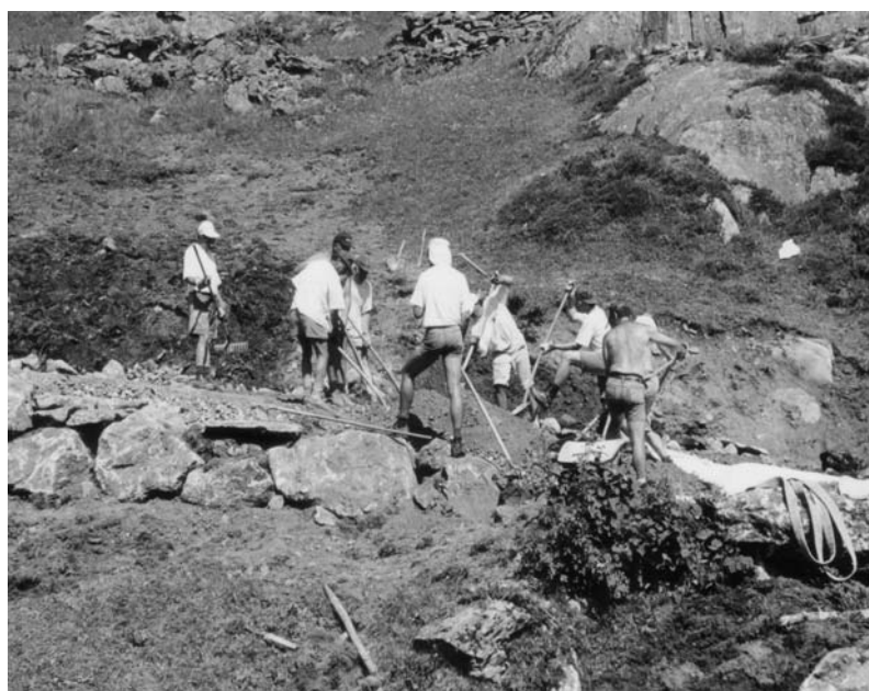
Strassenbau in Gurtellen 1995
